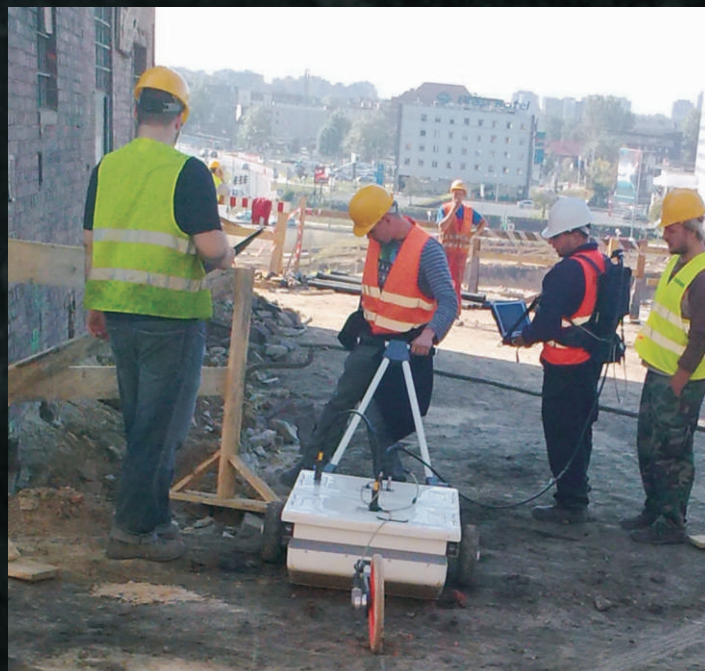
Pomiar georadarowy w celu rozpoznania struktury gruntów, granic geotechnicznych oraz spękań w masywie skalnym podczas prac budowlanych.
