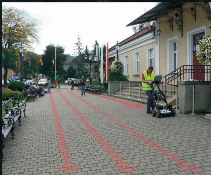
Pomiar georadarowy nawierzchni chodnika.
