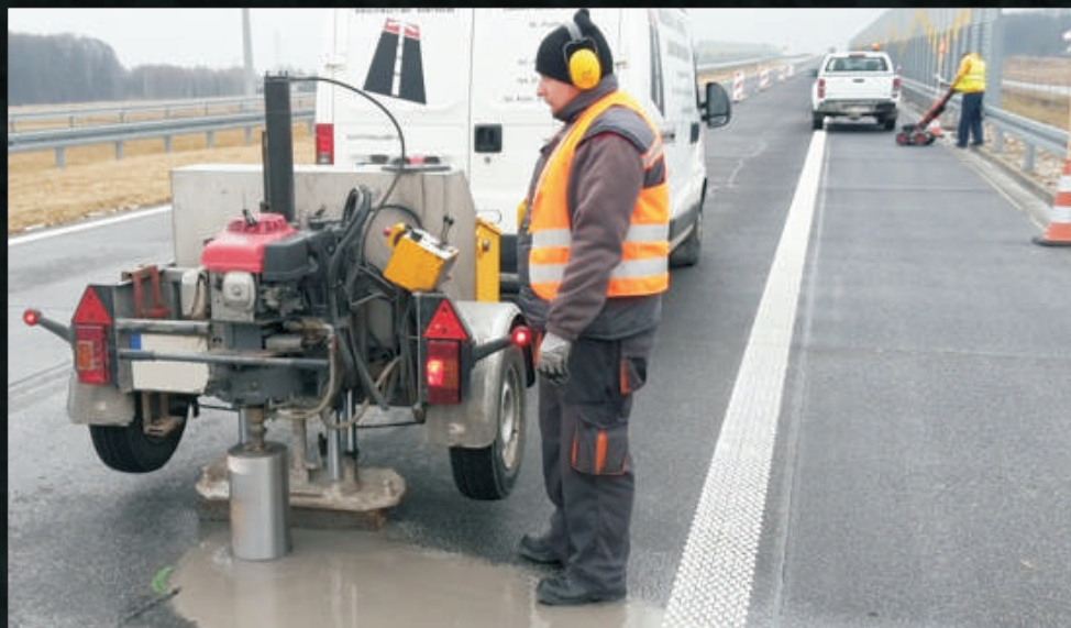
Wiercenie mechaniczne w warstwach nawierzchni autostrady w miejscach stwierdzonych usterek (u góry) oraz pozyskany rdzeń z dwóch wierzchnich warstw betonu z widocznym pęknięciem w górnej części, przedzielonych geowłókniną (po prawej).
