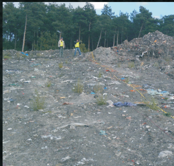
Pomiar sejsmiczny na składowisku odpadów komunalnych w celu określenia zasięgu głębokościowego warstw nasypowych i odpadów.
